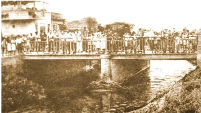
A la altura de calle Segurola
